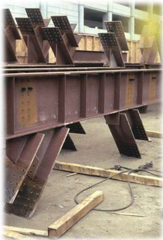
شکل ۶- ۳۹ نمونه های اجرایی بادبندهای برون محور [12]
