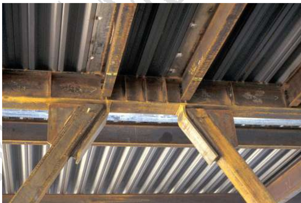
شکل ۶-۳۴ نمونه اجرا شده از فاصله مهار های جانبی [12]
