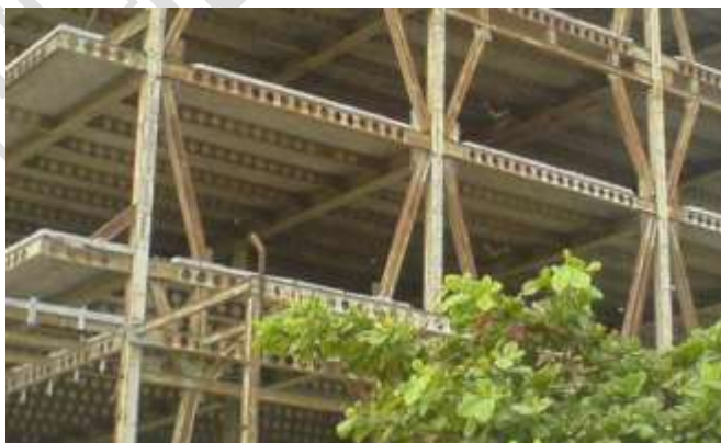
شکل ۳-۴ استفاده از تیر لانه زنبوری به عنوان تیر پیوند که مجاز نمی باشد.
