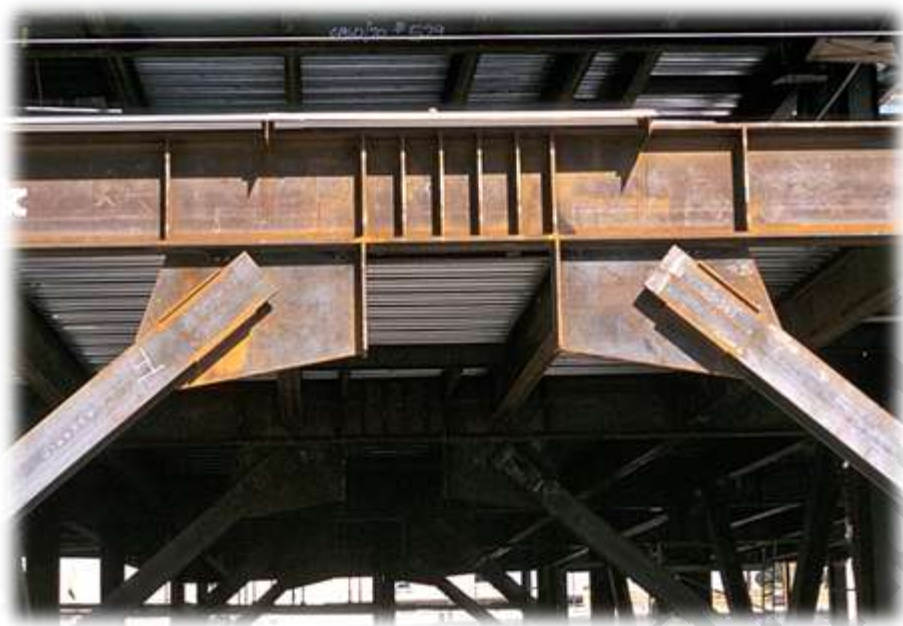
شکل ۶-۲۷ نمونه اجرا شده سخت کننده های میانی تیر پیوند [12]
