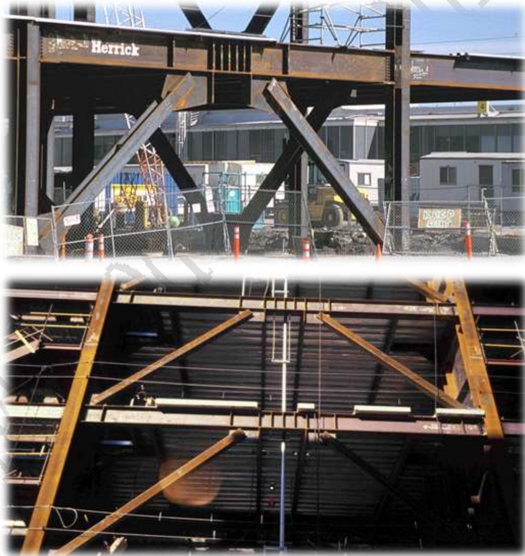
شکل ۱-۴ نمونه اجرا شده از بادبند برون محور EBF [12]
