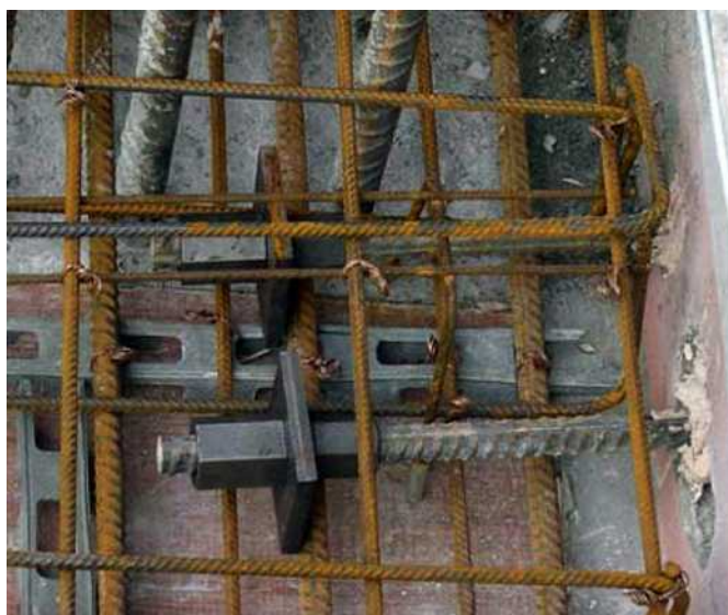
مهار شفت آسانسور با استفاده از مسلح‌کننده‌های Swiss-Gewi و میلگردهای تزریق‌شده در کف بتن مسلح موجود.
