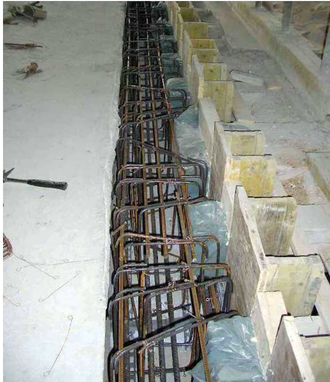
مهار آرماتورهای کف جدید در دیوارهای بنایی.
