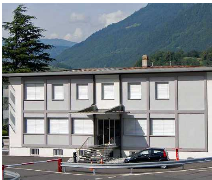
نمای دیوار طولی با دیوارهای جدید سازه‌ای بتن مسلح در منتهی‌الیه سمت راست.
