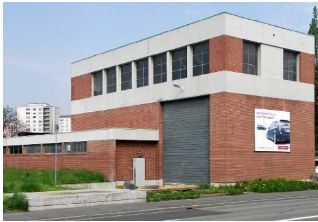
نمای خارجی تعمیرگاه الحاقی
