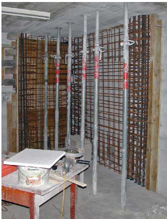
آرماتورگذاری یکی از دیوارهای جدید بتن مسلح در تراز زیرزمین.
