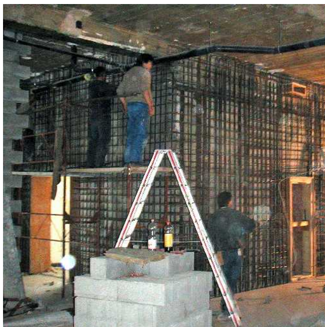
بستن قفسه‌های آرماتور دیوارهای بتن مسلح جدید در همکف.
