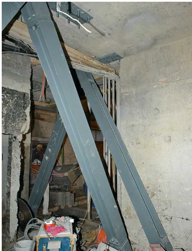
نصب خرپای فولادی جدید V شکل در طبقه همکف.
