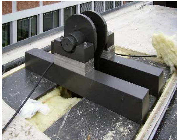
مهار فوقانی میله‌های کششی الیاف کربن در بام ساختمان که نیروی پیش‌تنیدگی را به میله‌ها وارد می‌کند.
