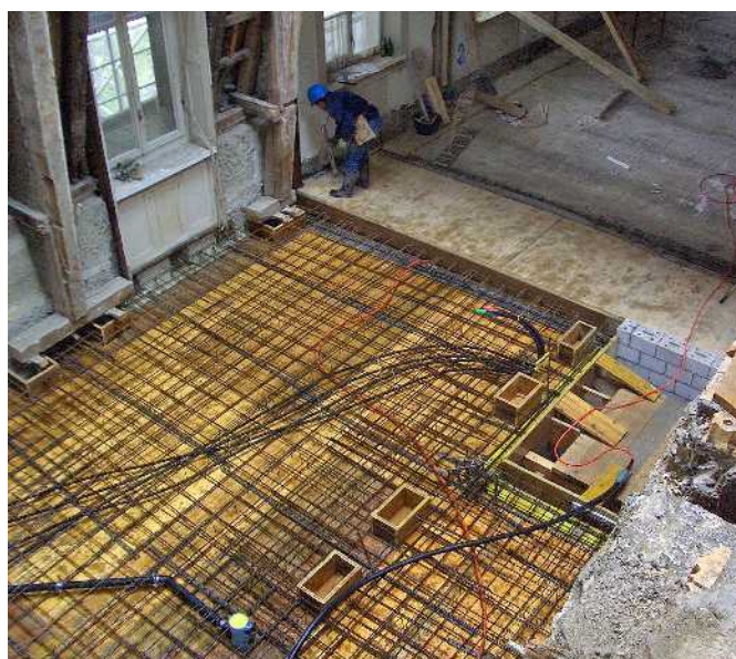
کف بتنی در ناحیه احداث شفت دسترسی جدید.
