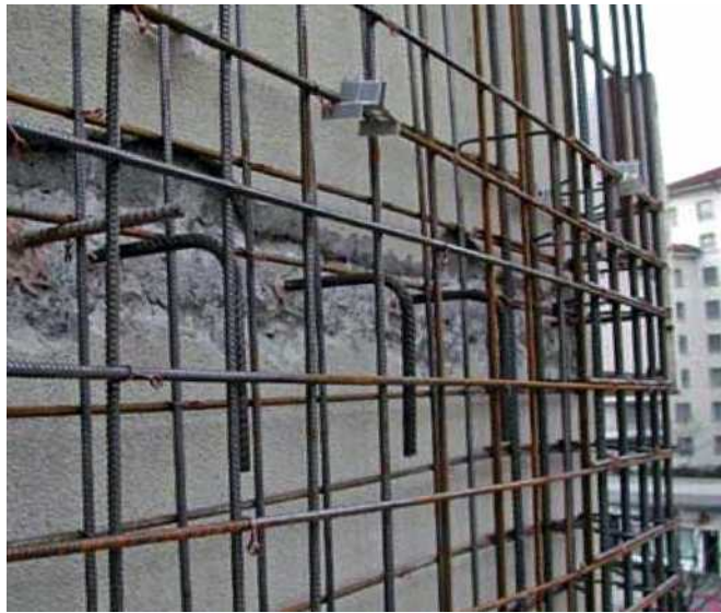
جزئیات آرماتوربندی دیوارهای سازه‌ای جدید به همراه شاخک‌های کاشته‌شده در دال کف موجود.
