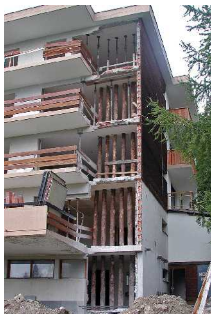
عملیات اجرایی در کنج جنوب شرقی ساختمان.
