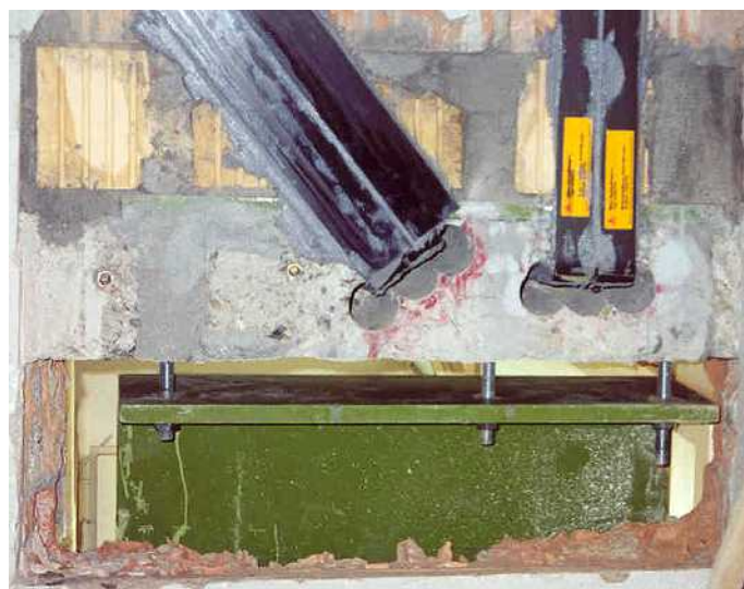
مهار تسمه‌های CFRP با استفاده از نبشی‌های برشی متصل به دال کف.
