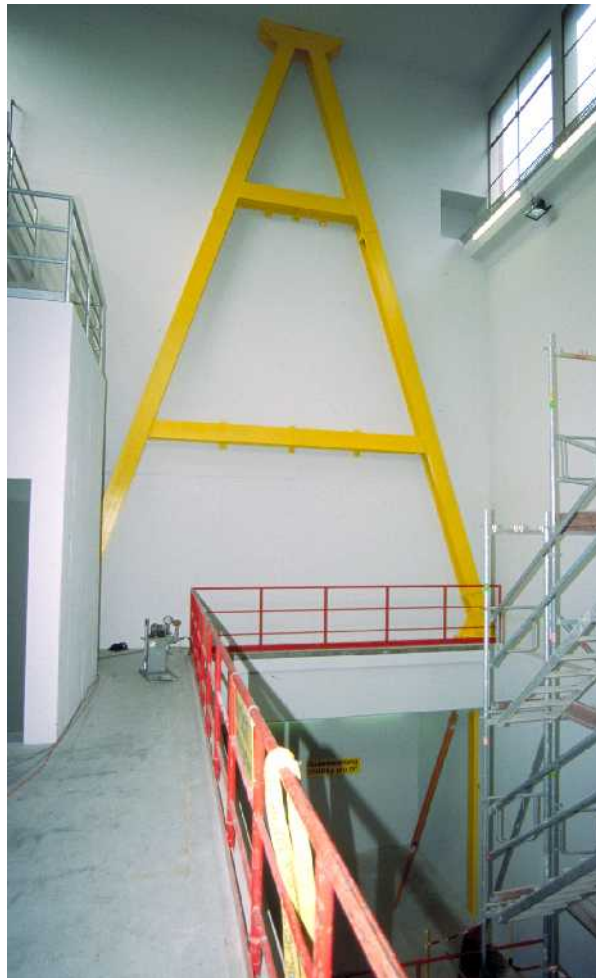
قاب فولادی A شکل جدید در ترازز همکف در نمای غربی و ورق‌های فولادی تقویتی در همکف.
