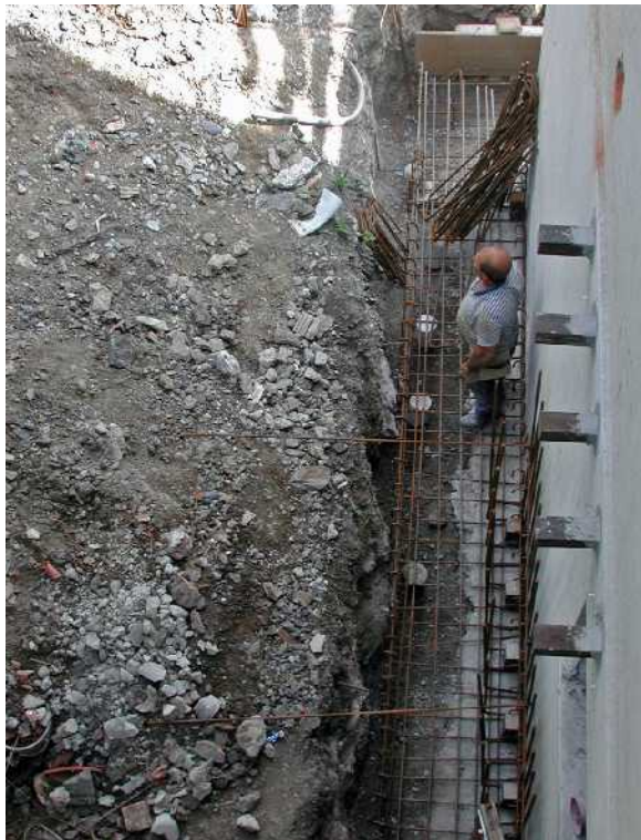
پی دیوارهای بتن مسلح جدید.
