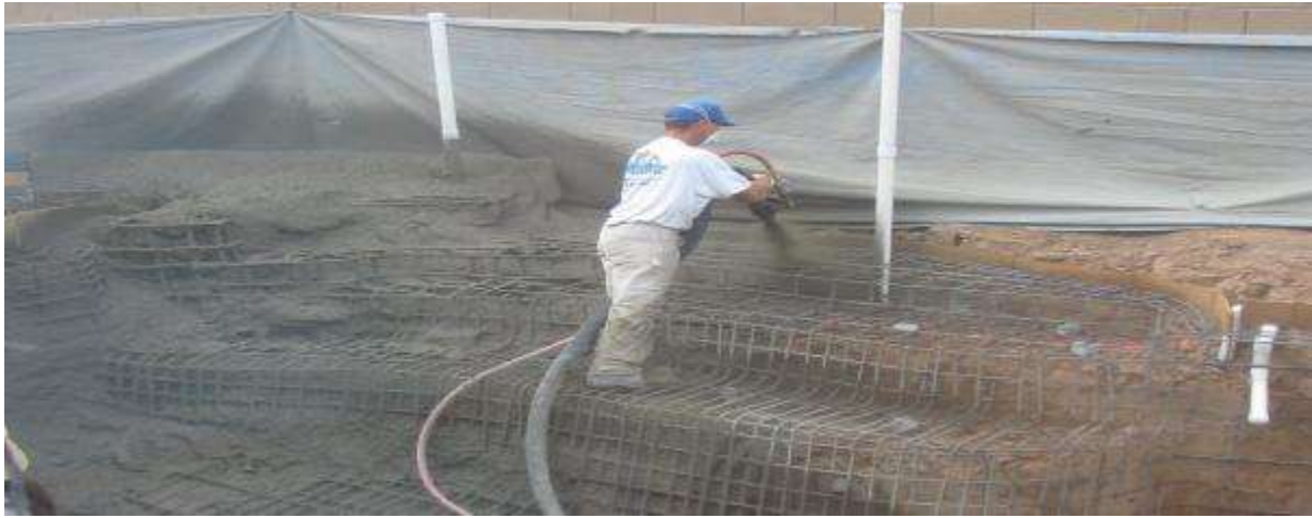
شاتکریت پشت آرماتورها تحت زاویه حداکثر ۴۵ درجه
