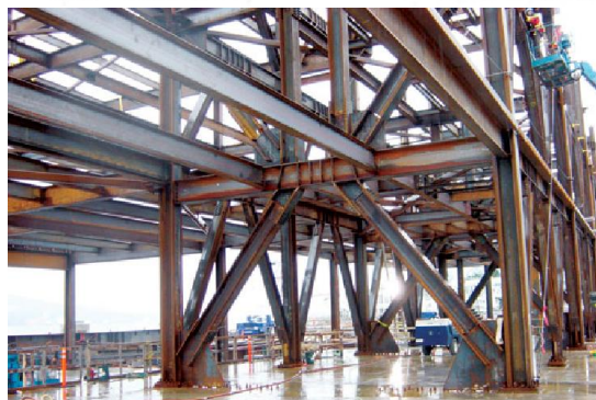
انواع قابهای مهاربندی برون محور (واگرا) EBF
