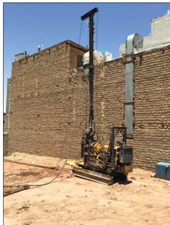
شکل ۲- حفاری به روش ماشینی؛ این روش بسته به جنس لایه‌ها، به روش‌های مختلفی مانند دورانی، ضربه‌ای و ... قابل انجام است.
