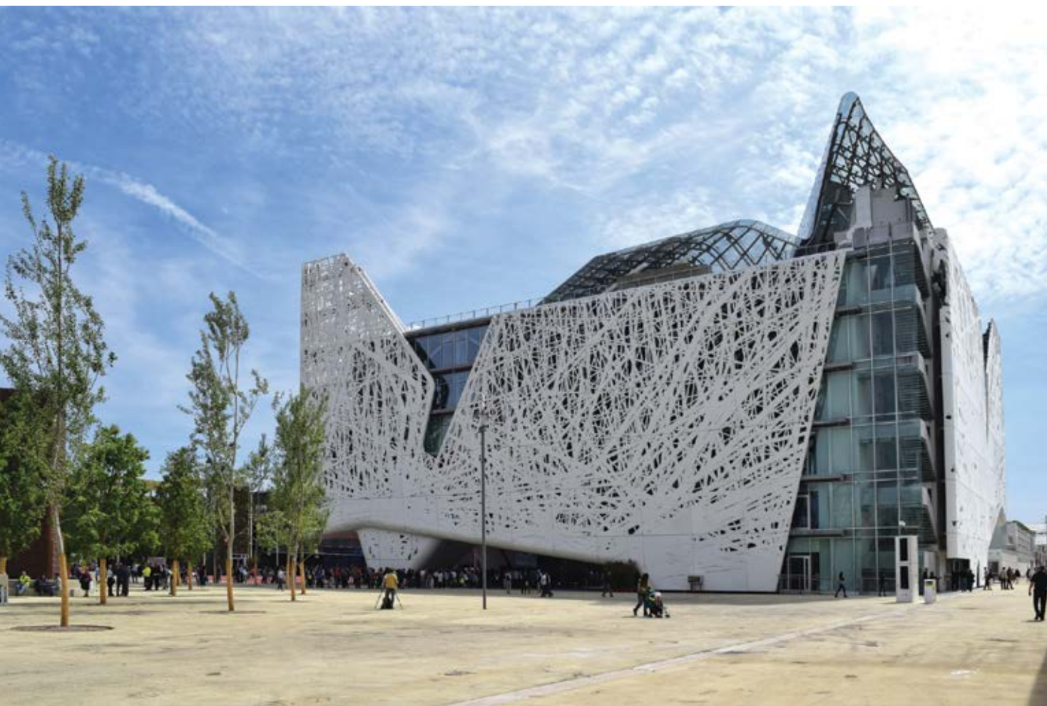
▲ غرفه کشور میزبان ایتالیا، با استفاده از سیمان فوتوکالیستی ساخته شده است که با جذب نور خورشید آلودگی موجود در هوا را گرفته و تبدیل به نمک می‌کند.
