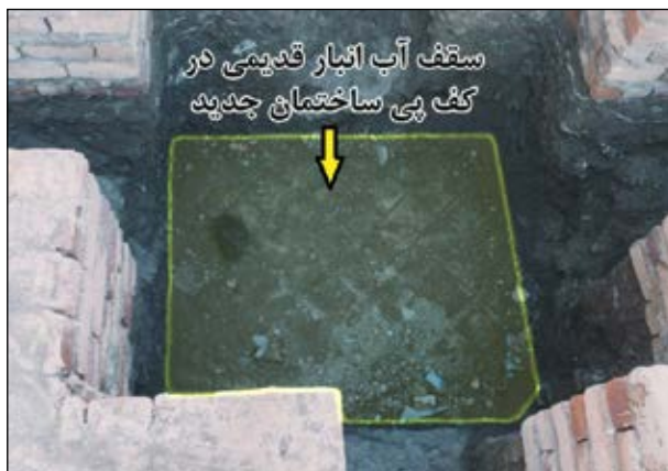
شکل ۱۰- برخورد به یک بنای مدفون قدیمی در حین پی سازی برای احداث ساختمان جدید
