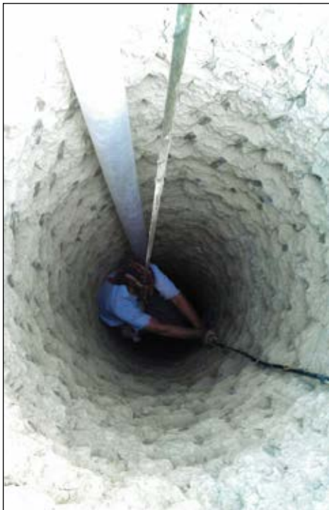
شکل ۱- حفاری به روش دستی؛ این روش معمولاً در زمین‌هایی قابل انجام است که جنس لایه‌ها متشکل از آبرفت بوده و دیواره‌ی چاه از خطر ریزش به دور باشد.
