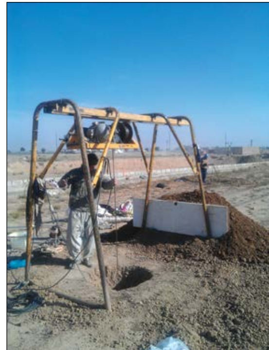
شکل ۱- حفاری به روش دستی؛ این روش معمولاً در زمین‌هایی قابل انجام است که جنس لایه‌ها متشکل از آبرفت بوده و دیواره‌ی چاه از خطر ریزش به دور باشد.
