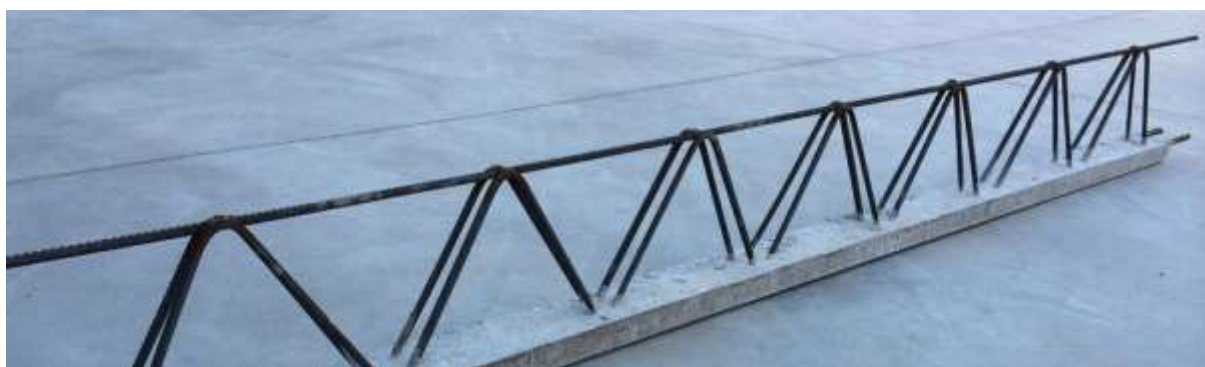
شکلی از تیرچه هایی با پاشنه بتنی
