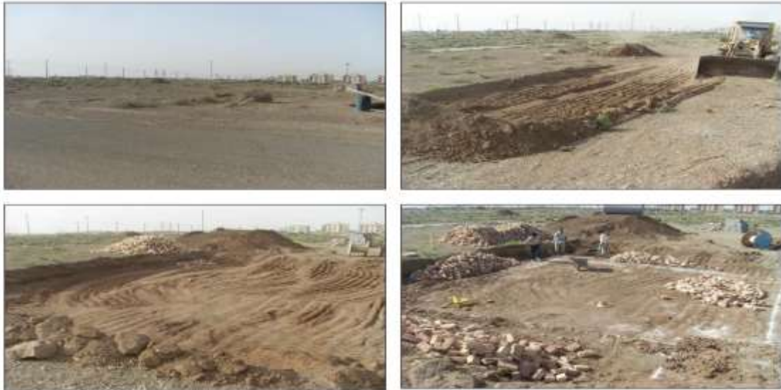
تصویر ۱۸- آماده سازی (تسطیح و خاکبرداری) زمین در ۳ ساعت
