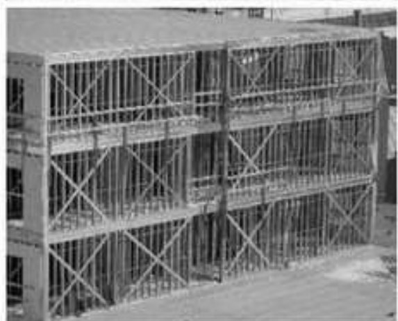
شکل (۴) دیوارهای برشی در سیستم LGS
