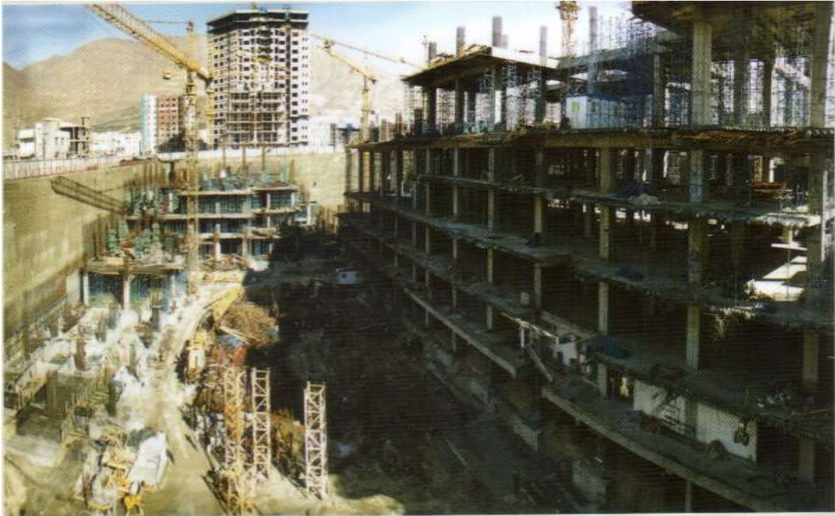
مجتمع تجاری تفریحی تهران مال محل پروژه: تهران، منطقه ۲۲ بلندترین دهانه: ۱۶ متر ضخامت دال: ۳۵ - ۴۰ - ۶۰ سانتی متر زیربنا: ۱۴۰۰۰۰ متر مربع
