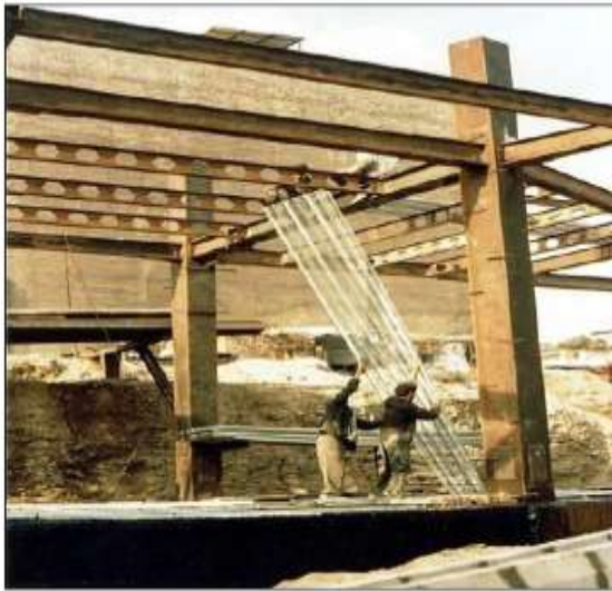
حمل روفیکس به طبقات بالاتر بدون استفاده از بالابر
