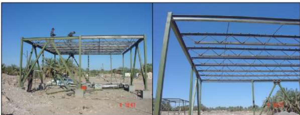
تصویر ۱۲ - نصب سریع تیرهای دلتا
