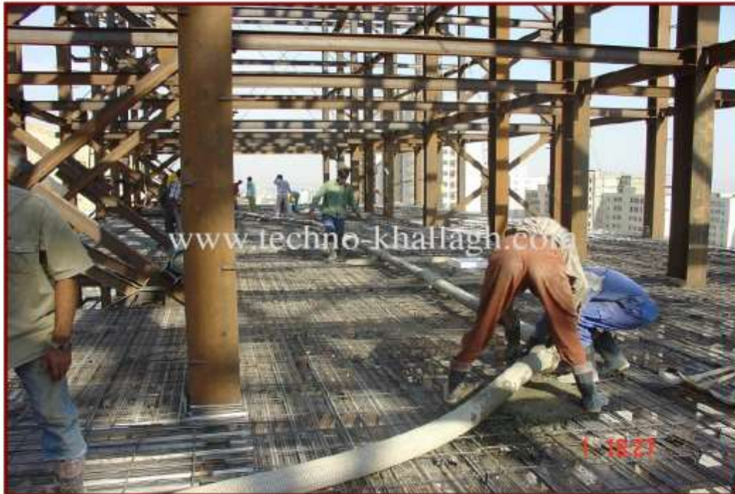
۵- بتن ریزی طبقه پنجم با استفاده از پمپ
