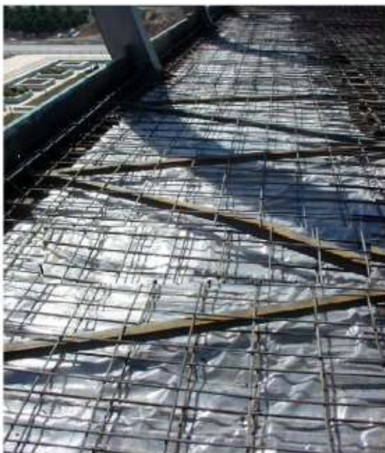
نصب قالب روفیکس و کشیدن یک لایه پلاستیکی برای جلوگیری از ریختن سیره بتن با اسلایب بالا
