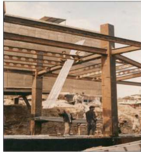
حمل روفیکس به طبقات بالاتر بدون استفاده از بالابر
