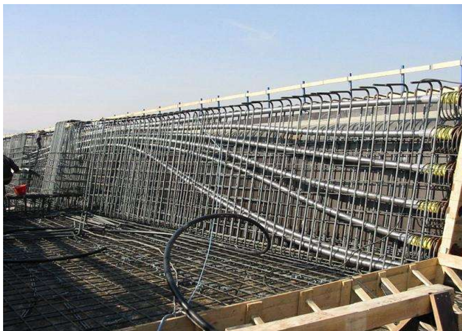
پل صندوقه ای در جازیز
