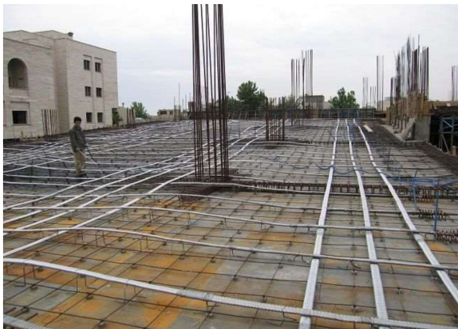
سقف ساختمان پس کشیده
