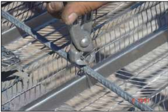
تصویر ۱۳ - نصب روفیکس و شبکه آرماتور
