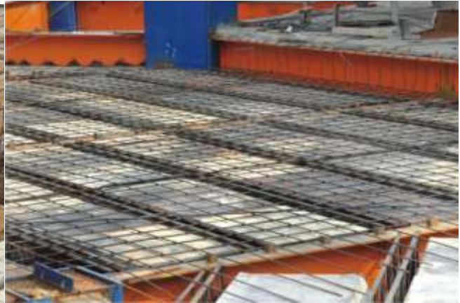
۳. آرماتوربندی (آرماتور حرارتی) و بتن ریزی
