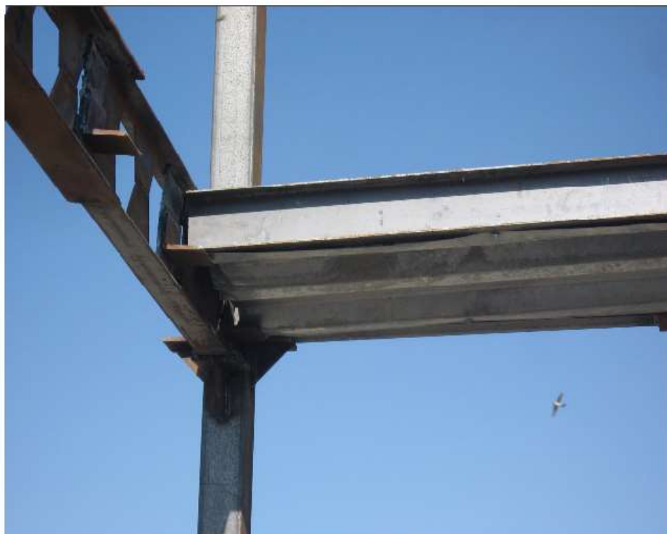
نحوه قرار گیری سقف بر روی نبشی نشیمن
