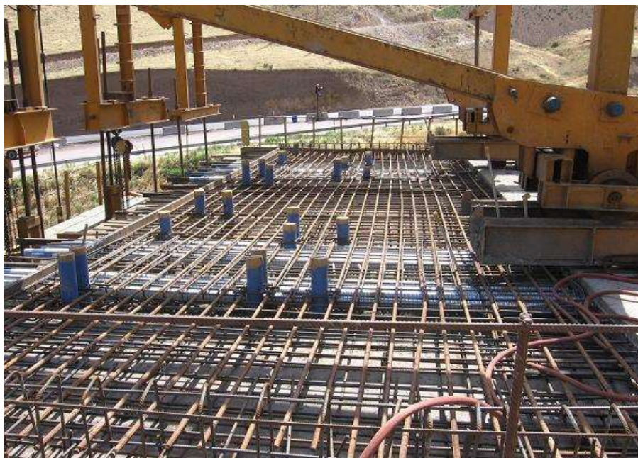
پل صندوقه ای به وسیله دستگاه شاریو
