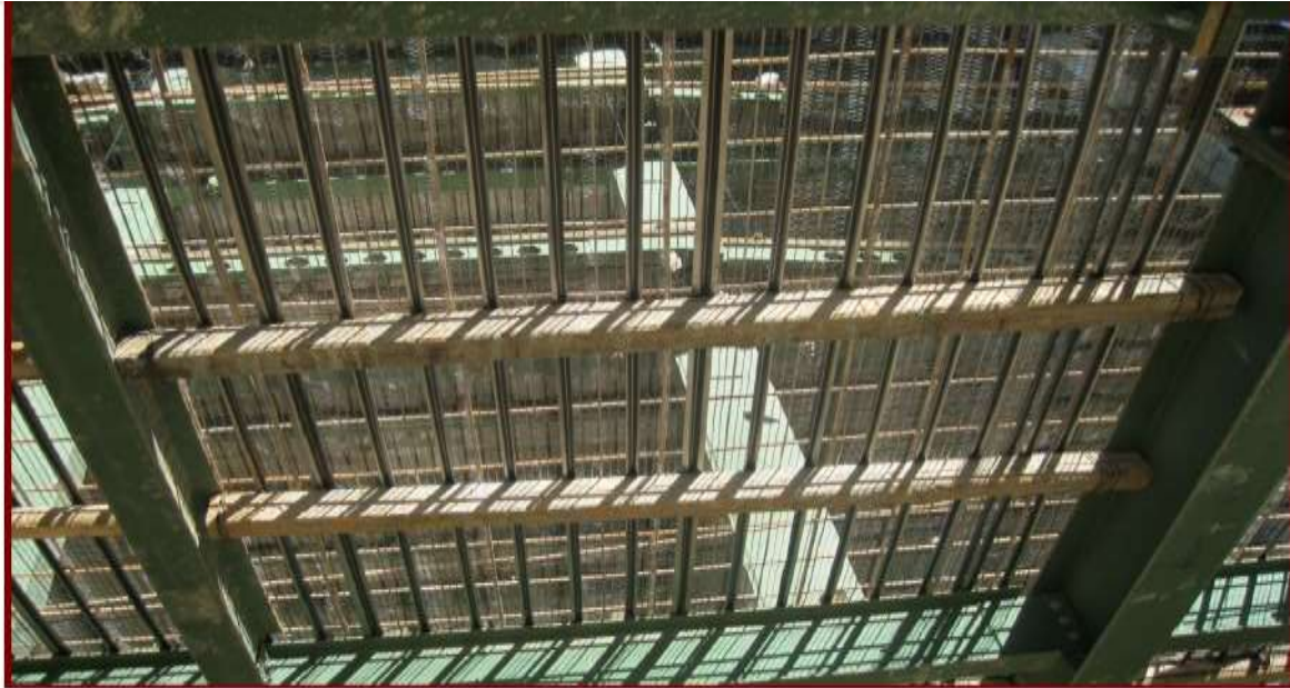
قالب بندی با روفیکس (نسل اول) برای دهانه های ۲/۷ متری. پروژه پالایشگاه ایلام.
