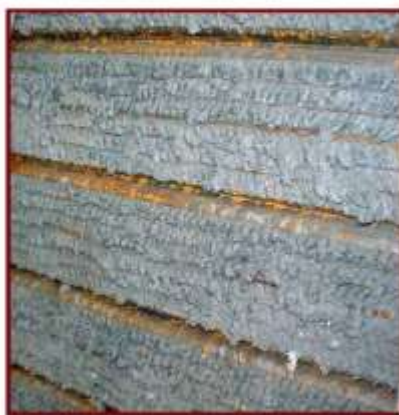
فرورفتن بتن در شبکه روفیکس سطحی بسیار زبر و ناهموار را بوجود می‌آورد
