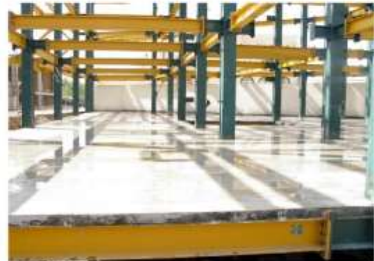
استفاده از بتن خودتراکم (SCC) با اسلامپ بالا، با روش سنجاقک بدون خطر از دست رفتن بتن
