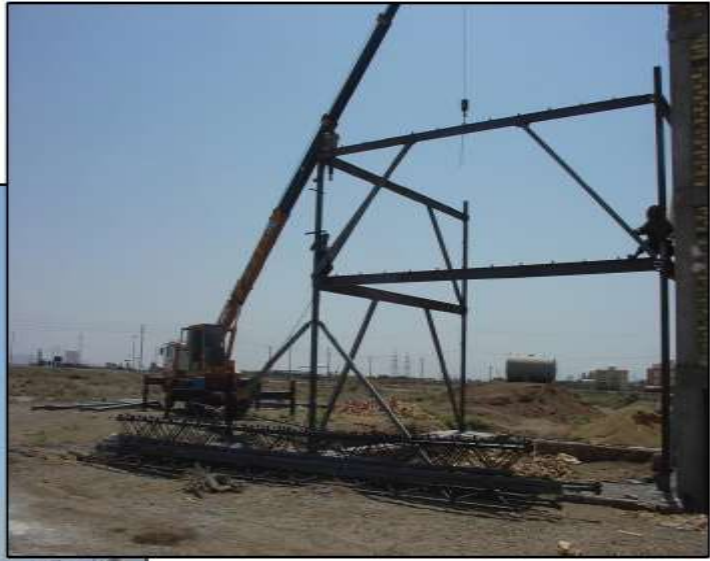
نصب اسکلت و تیرهای دلتا هر دو طبقه در ۸ ساعت
