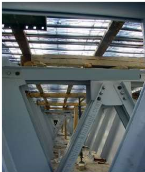
نصب قالب روفیکس و کشیدن یک لایه پلاستیکی برای جلوگیری از ریختن سیره بتن با اسلایب بالا
