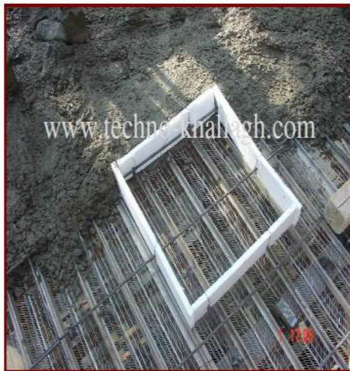
۶- قالب بندی پیرامون بازشوها برای جلوگیری از پیشروی بتن به فضای داخل آنها
