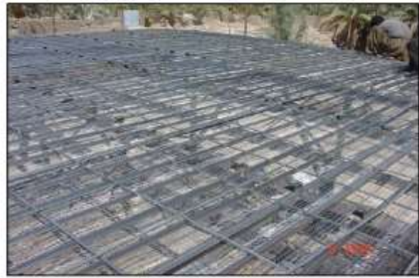
تصویر ۱۳ - نصب روفیکس و شبکه آرماتور
