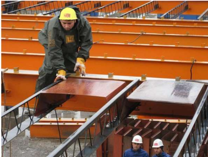
۲. نصب و فیکس کردن قالب
