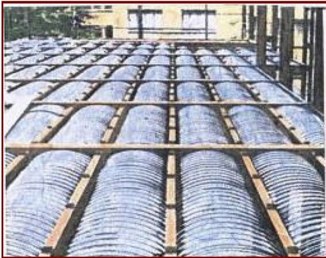
اجرای تاق ضربی بتنی در آلمان
