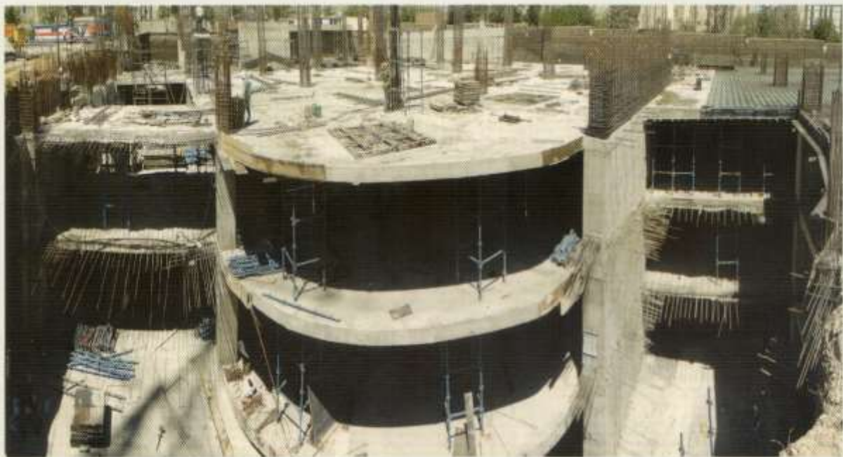
پارکینگ طبقاتی کارستان محل پروژه تهران بلندترین دهانه ۱۱/۵ متر ضخامت دال ۳۲ سانتی متر زیربنا ۴۲۵۰۰ متر مربع
