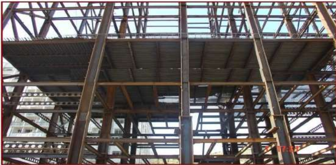
۷- بتن ریزی طبقه پنجم بدون استفاده از شمع، جک و یا زیربندی
