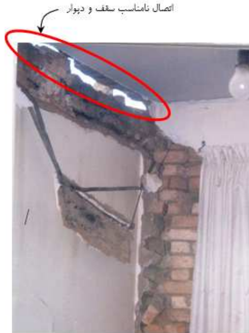
اتصال نامناسب بین دیوار و سقف
