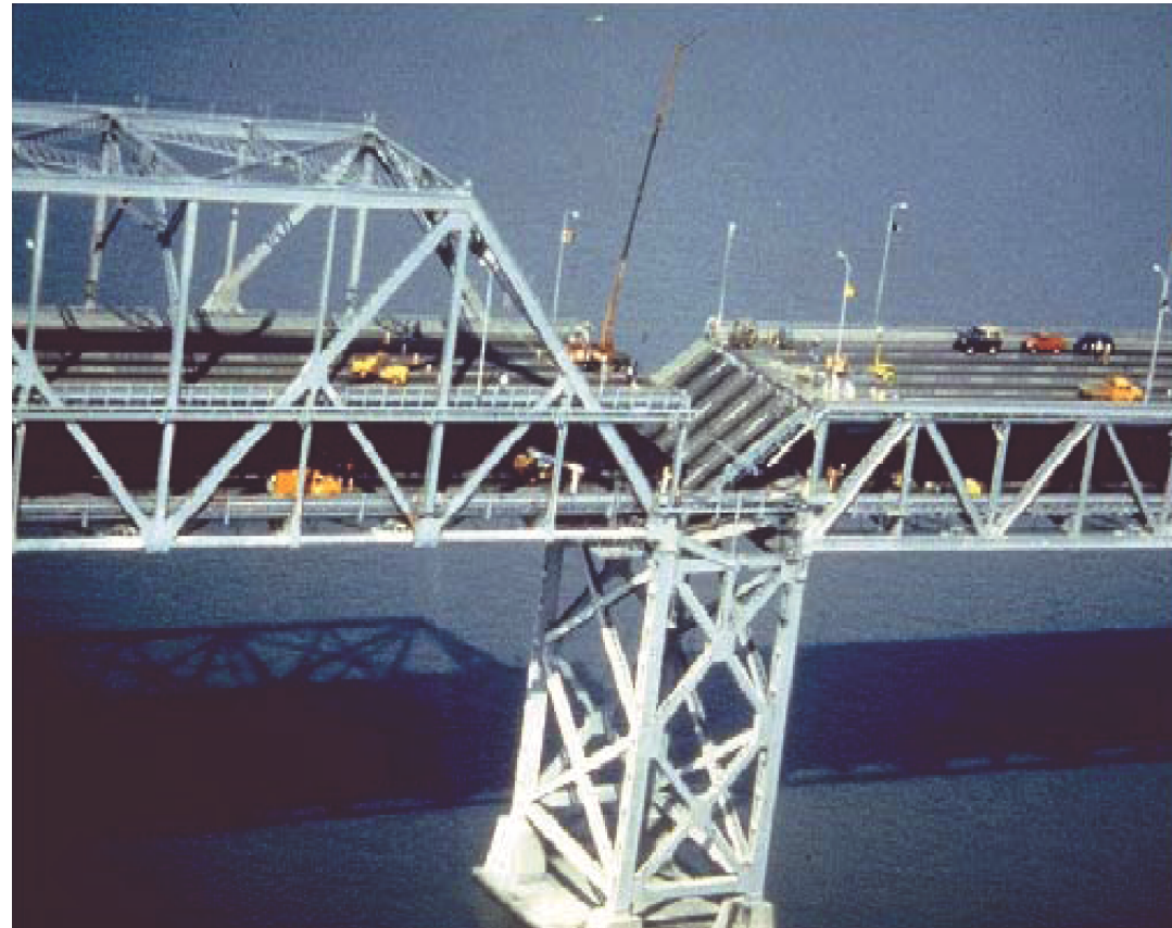
تخریب عرشه‌ی پل
