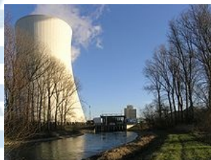
شکل ۲: برج خنک کننده و تخلیه آب چیلر نیروگاه هسته ای
