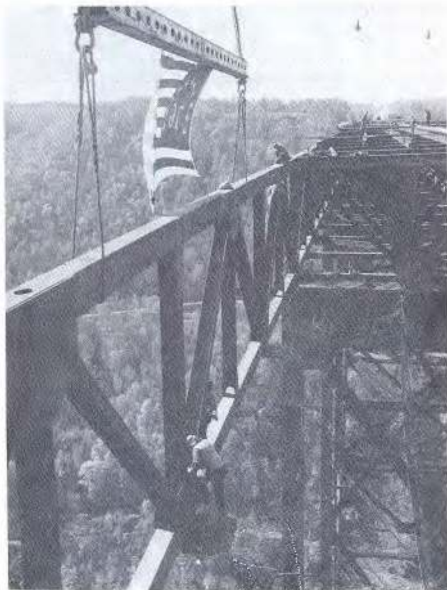
عملیات نصب پل فولادی
