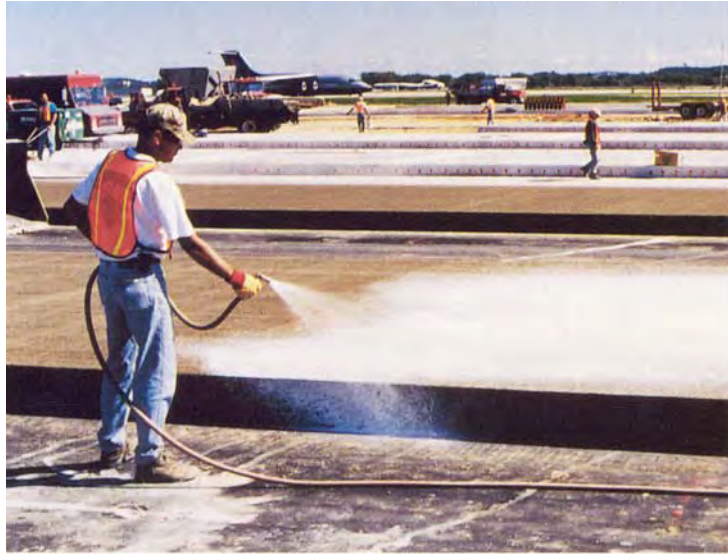
شکل ۴ روش عمل‌آوری با ماده شیمیایی غشایی
