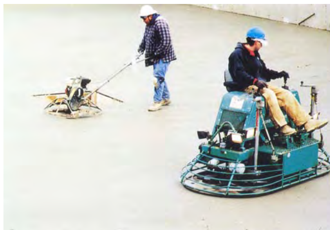
شکل ۶ پرداخت نهایی با ابزار مکانیکی
