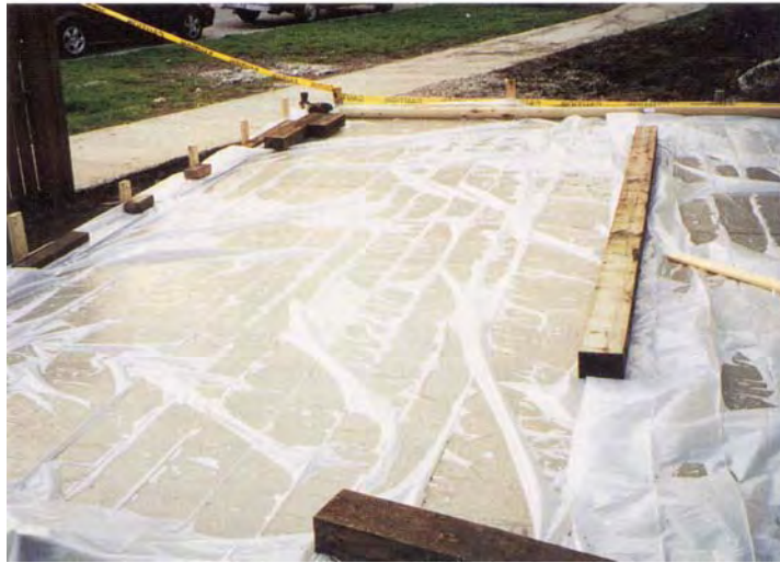
شکل ۲ عمل آوری با پلاستیک
