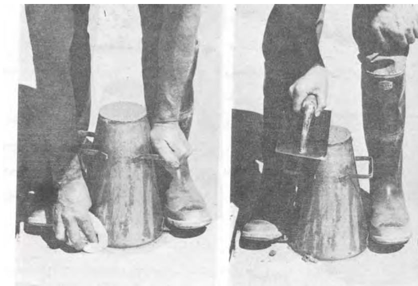
شکل ۴ صاف کردن سطح بتن و تمیز نمودن اطراف مخروط اسلامپ
