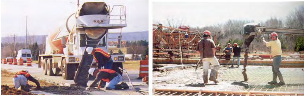
شکل ۲ ریختن بتن در نزدیکی محل مورد نیاز
