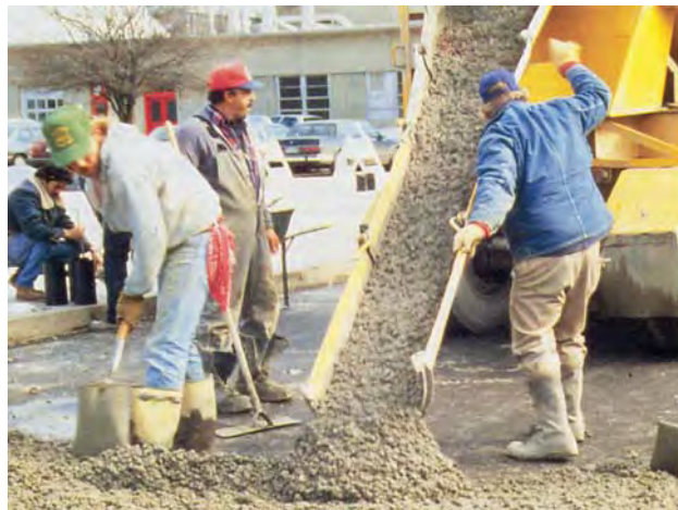
شکل ۴ انتقال بتن با استفاده از سطح شیب‌دار
