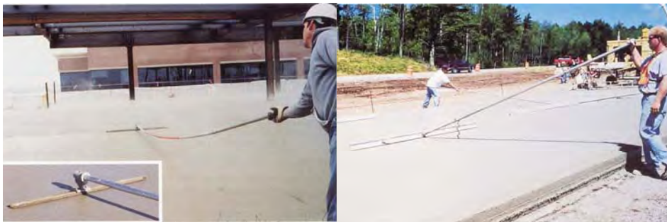
شکل ۳ تخته ماله کشی با تخته ماله دسته بلند
