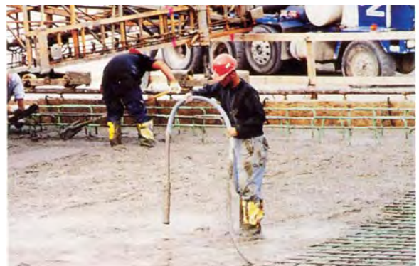
شکل ۴ همپوشانی، شعاع عمل ویبراتور و انجام شدن ویبره به صورت عمودی (تعیین فواصل نفوذ ویبراتور)
