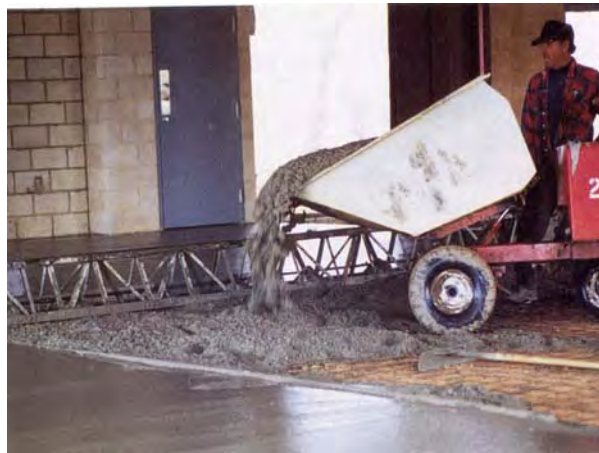
شکل ۳ روش صحیح ریختن بتن
