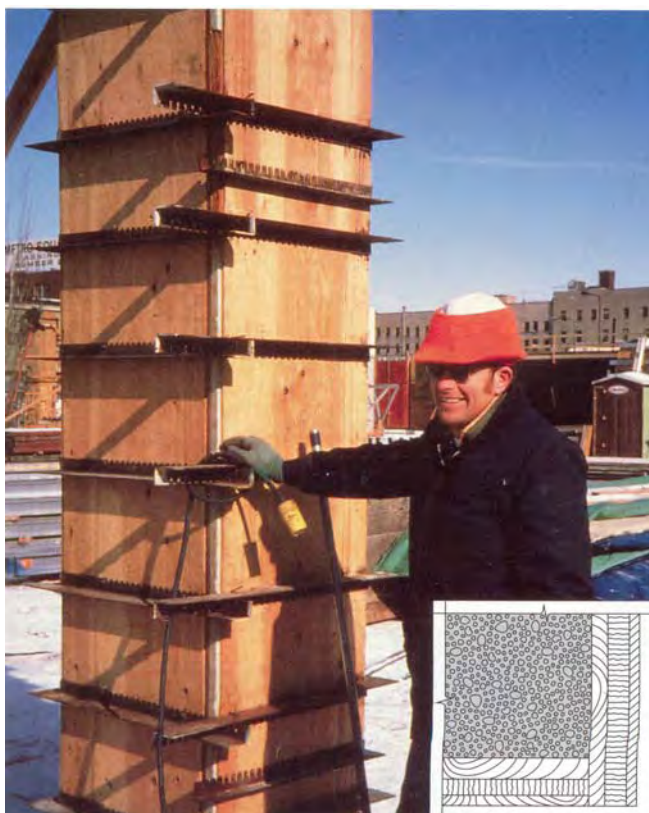
شکل ۵ استفاده از قالب‌های چند لایه برای عمل آوری در هوای سرد
