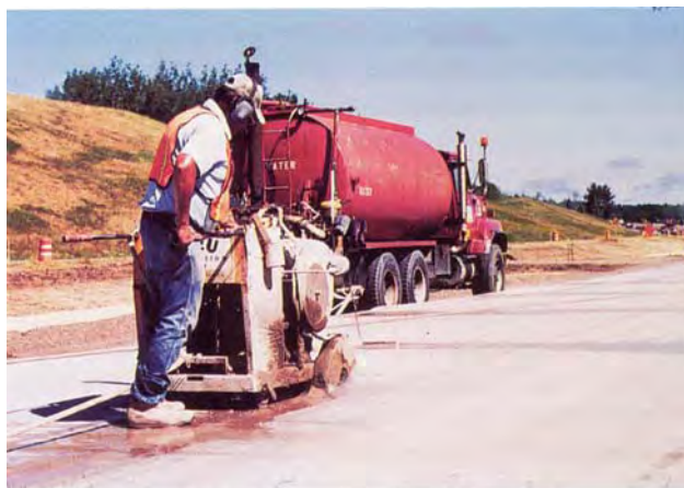
شکل ۱ استفاده از دستگاه برش برای ایجاد درز
