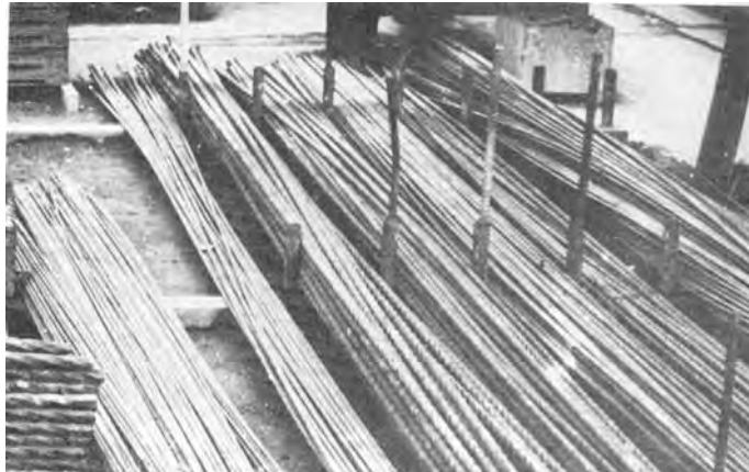
شکل ۷ نحوه صحیح نگهداری میلگردها
