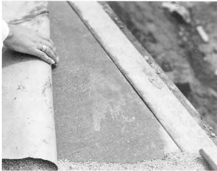
شکل ۳ عمل آوری عایقی (پوشش‌های مرکب)
