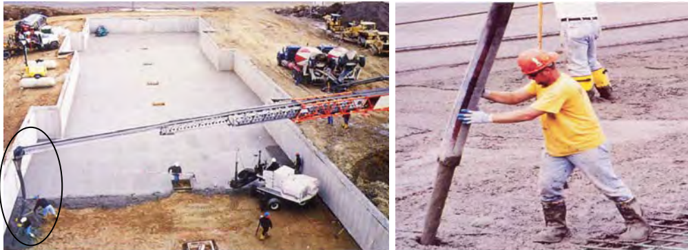
شکل ۵ - شوت قوطی، سمت راست انتقال بتن با استفاده از شوت سقوطی، سمت چپ ترکیب ناوه و شوت سقوطی
