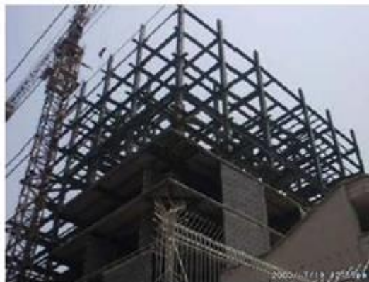
شکل ۲) عمده ساختمانهای بلند در تهران با اسکلت فولادی و اتصالات گیردار اجرا می شوند که نیاز به تامین شرایط ویژه کنترل کیفی جوش دارند.
